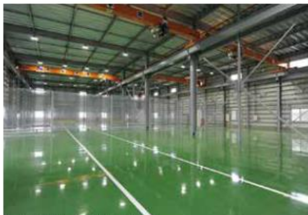
▲完成したばかりの南松永第3工場。 ここを成功させるためにも人材は必要となる
